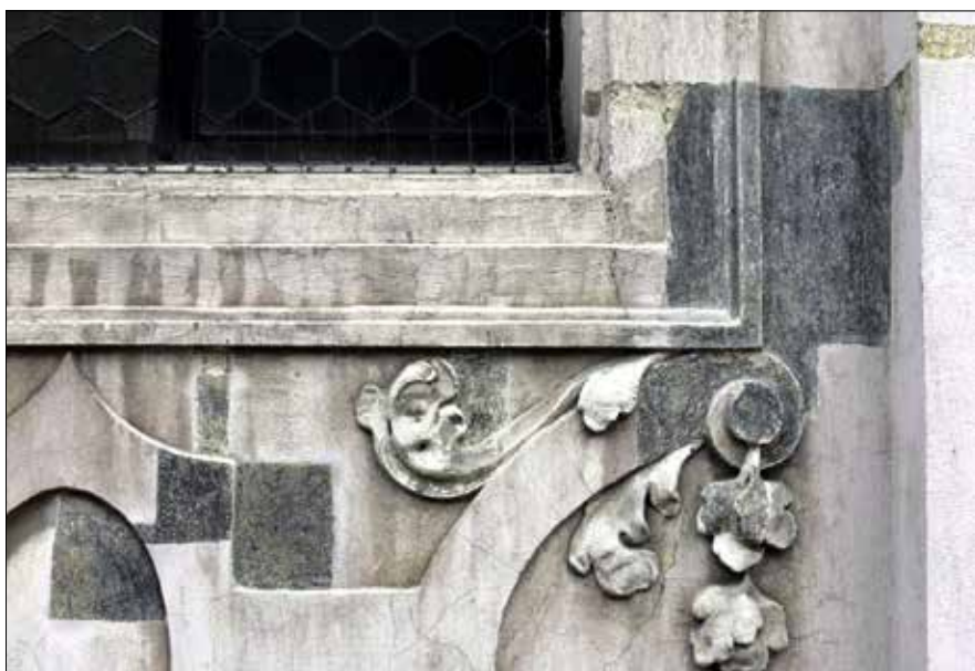
Obr. 26. Sondážně odhalený povrch omítky s výrazně šedou barevností. Kompaktnost a homogenita povrchu i jednodušost šedého zbarvení v praxi může vést k domněnce, že se jedná o nátěr černé či tmavě šedé barevnosti. Jak dokládá obrázek 27, stratigrafický průzkum v těchto případech obvykle dobře odliší nátěr od znečištění.
