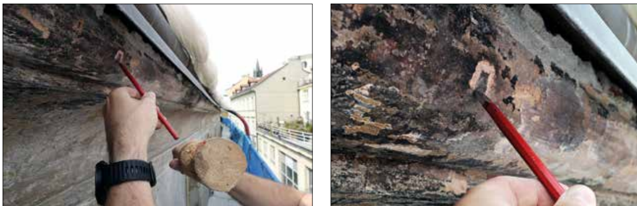
Obr. 4 a 5. Informační hodnotu odebraných vzorků ovlivňuje nejen vytipování místa, ale také zoládnutá technika odběru vzorků a použití přiměřených nástrojů. Při odběru je třeba zajistit, aby vzorek obsahoval celé souvrství úprav z vytipovaného místa včetně podkladu.
