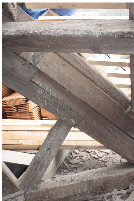
Obr. 29. Velká Černoc, kostel sv. Václava – detail precizní opravy úžlabní krokve, provedené ve 20. letech 20. století. Foto: Lucie Radová, 2009.
