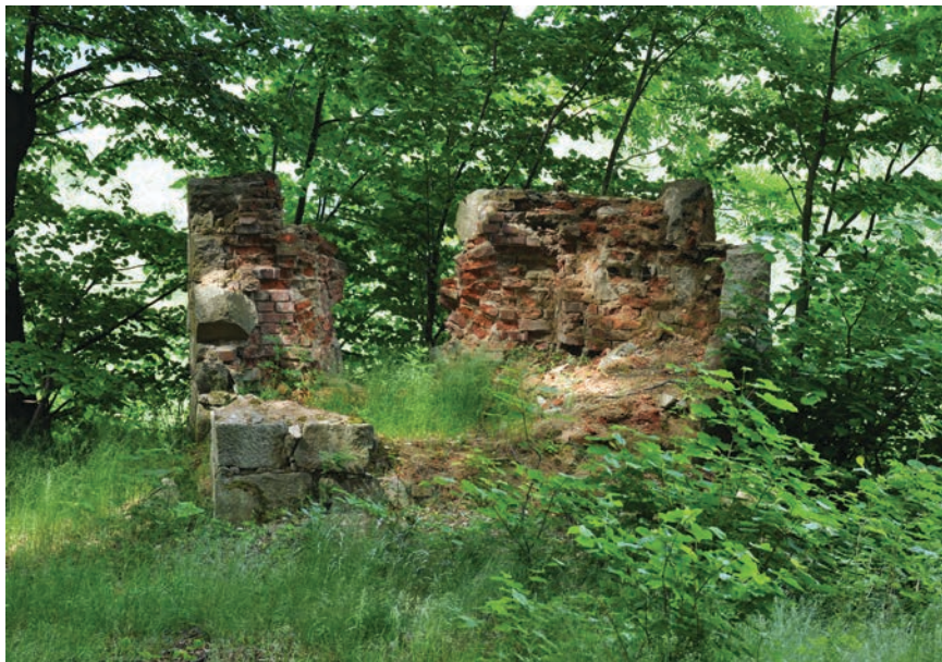
Obr. 2. Šluknov – Království, Kaple žaláře Krista, pohled od východu, v čelní západní straně je patrný relikt oválného okenního otvoru s koutovými výběhy po nasazení klenby. Foto: Táňa Nejezchlebová, 2012.
