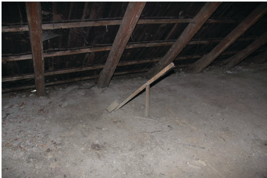
Obr. 30. Minice, kostel sv. Martina – detail závěsného zařízení (kladky) v prostoru krovu nad severním bočním oltářem k zavěšení lampy na věčné světlo. Foto: Lucie Radová, 2008.
