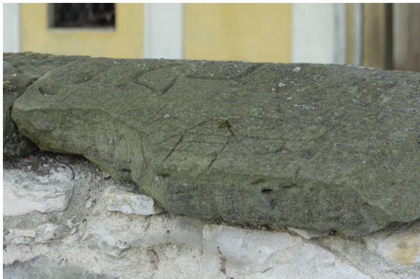
Obr. 12. Telce, kostel sv. Mikuláše – zajímavá rytina nespécifikované stavby na kamenné desce kryjící ohradní zeď kostela vyžaduje rovněž dokumentační podchycení. Foto: Lucie Radová, 2011.
